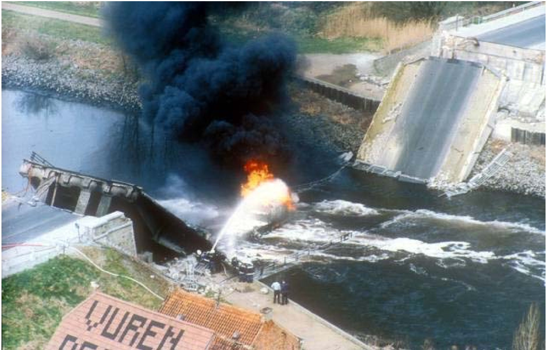
The River Scheldeに架かるPC橋の落橋 (ベルギー1992年)
