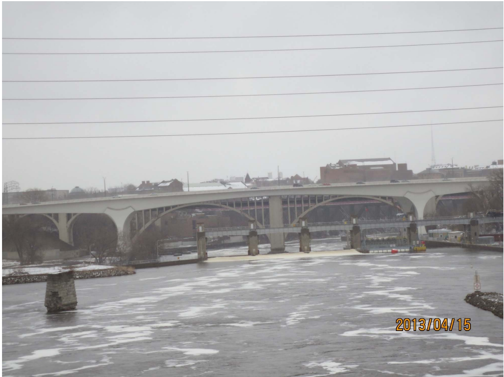
セントアンソニーフォールズ橋(PC箱桁橋:370m)
