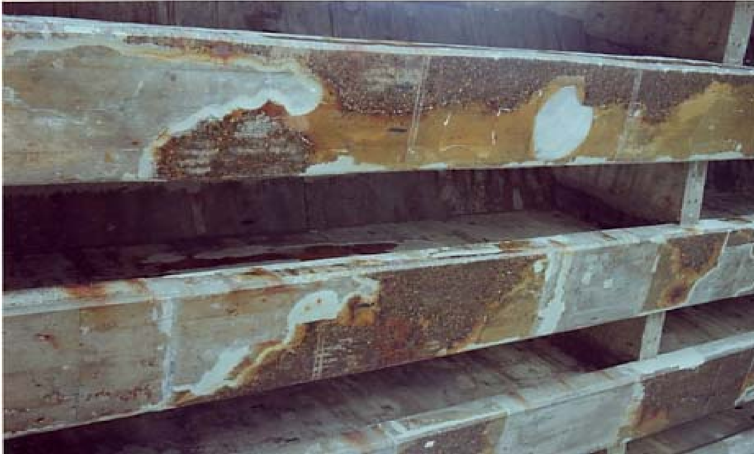
エポキシ樹脂 による補修
