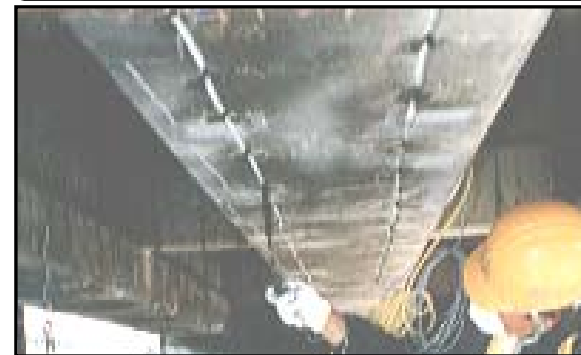
チタンロッド挿入工法
