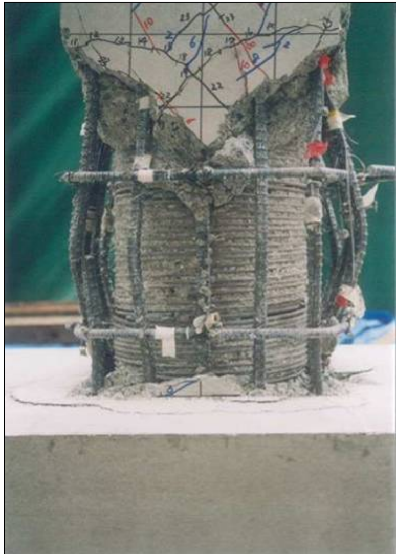
内巻スパイラル鉄筋の配筋方法（20 \delta_y 載荷終了後）
