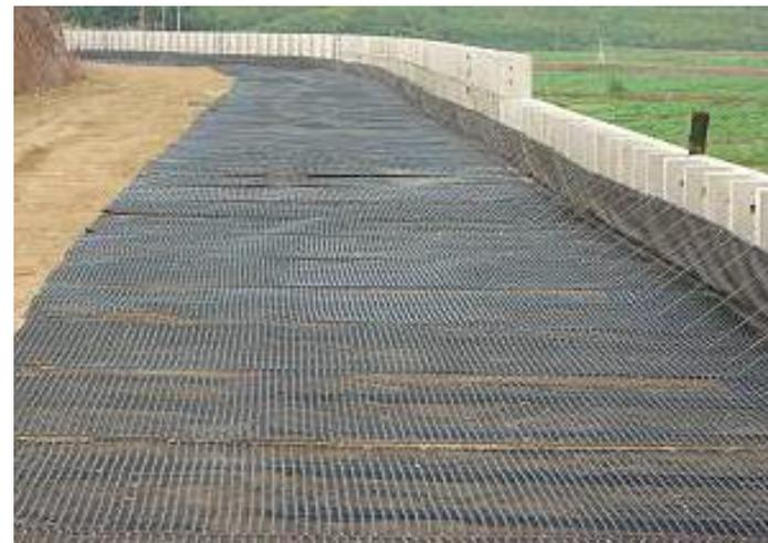
補強土壁工法
