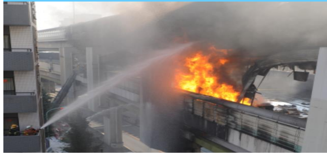
JR武蔵野線火災:2日間に廃タイヤの燃焼: 消火不能 1,200度に長期に暴露
