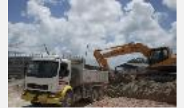
ゼネコンが建設現場で導入 建機遠隔制御
