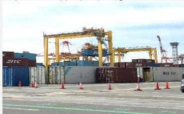
港湾管理者が導入 ターミナル遠隔監視
