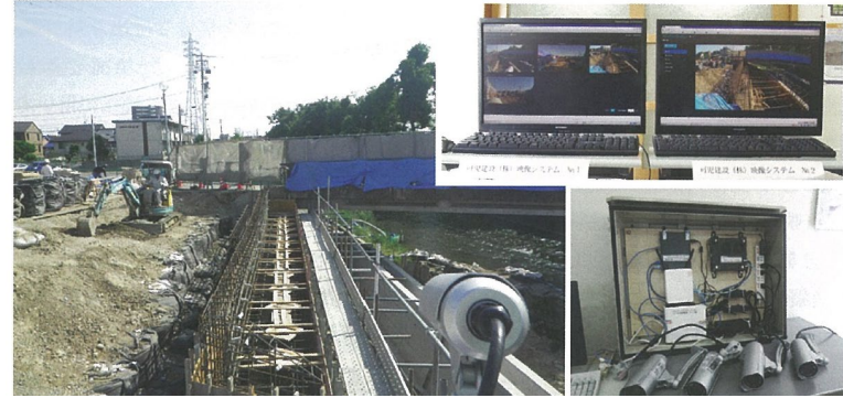
映像撮影の様子 (現場を1日中撮影、リアルタイム映像の視聴も可能)
