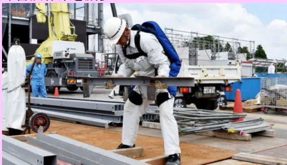
災害現場における重量物運搬の例
