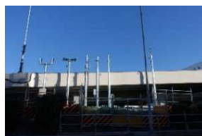
センサ① (本線車両の速度・車長・車間の検知)
