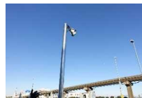
路側無線装置
